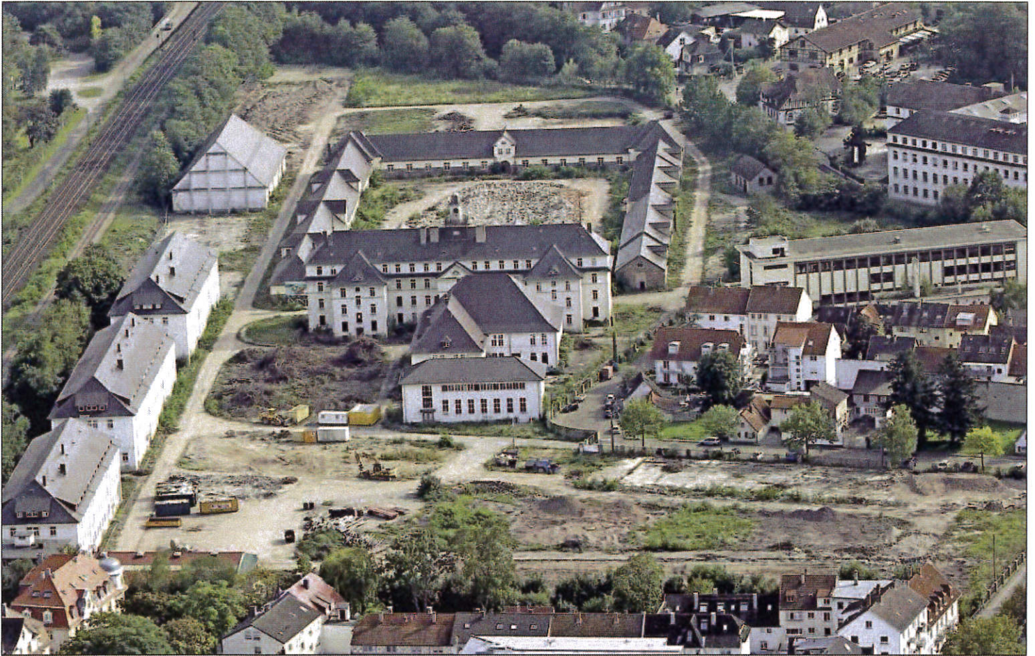
Die Abrissarbeiten sind beendet; jetzt läuft auf dem Joffre-Areal der Straßenbau.
